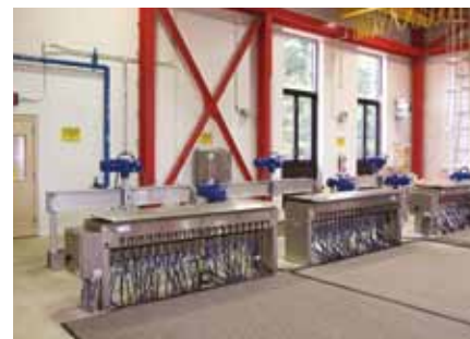
Figure 2. Le système de désinfection TrojanUV3000Plus™ est entièrement validé par un organisme tiers et jouit d'une garantie de rendement de désinfection à vie. Les usines peuvent être assurées que le calibrage du système UV de Trojan est précis et fonctionnera comme prévu.
