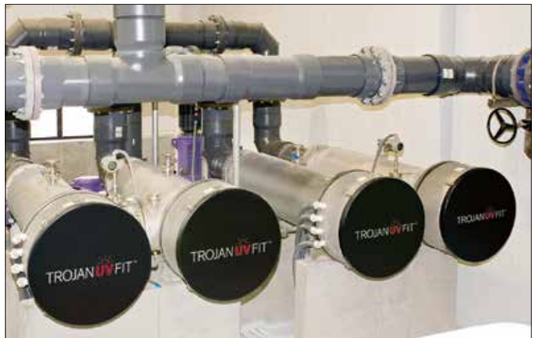
Les réacteurs peuvent être installés en parallèle ou en série afin d'accroître la flexibilité des installations et de la conception
